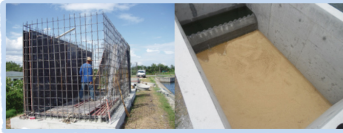
การติดตั้งและเดินระบบทลายกรองซ้ำ
