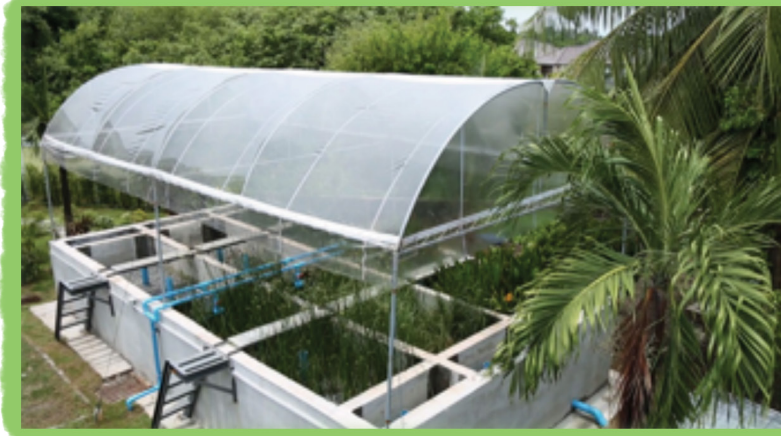
ระบบบึงประดิษฐ์ที่ใช้บำบัดน้ำเสียโรงพยาบาลที่ป็นเพื่อนผลิตภัณฑ์ยา
